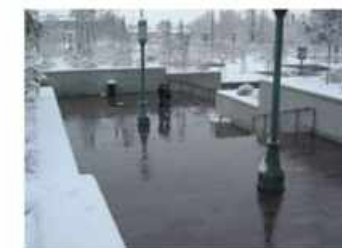
przykład wykonanej i funkcjonującej instalacji pod nawierzchnią dużych nawierzchni tarasowych
